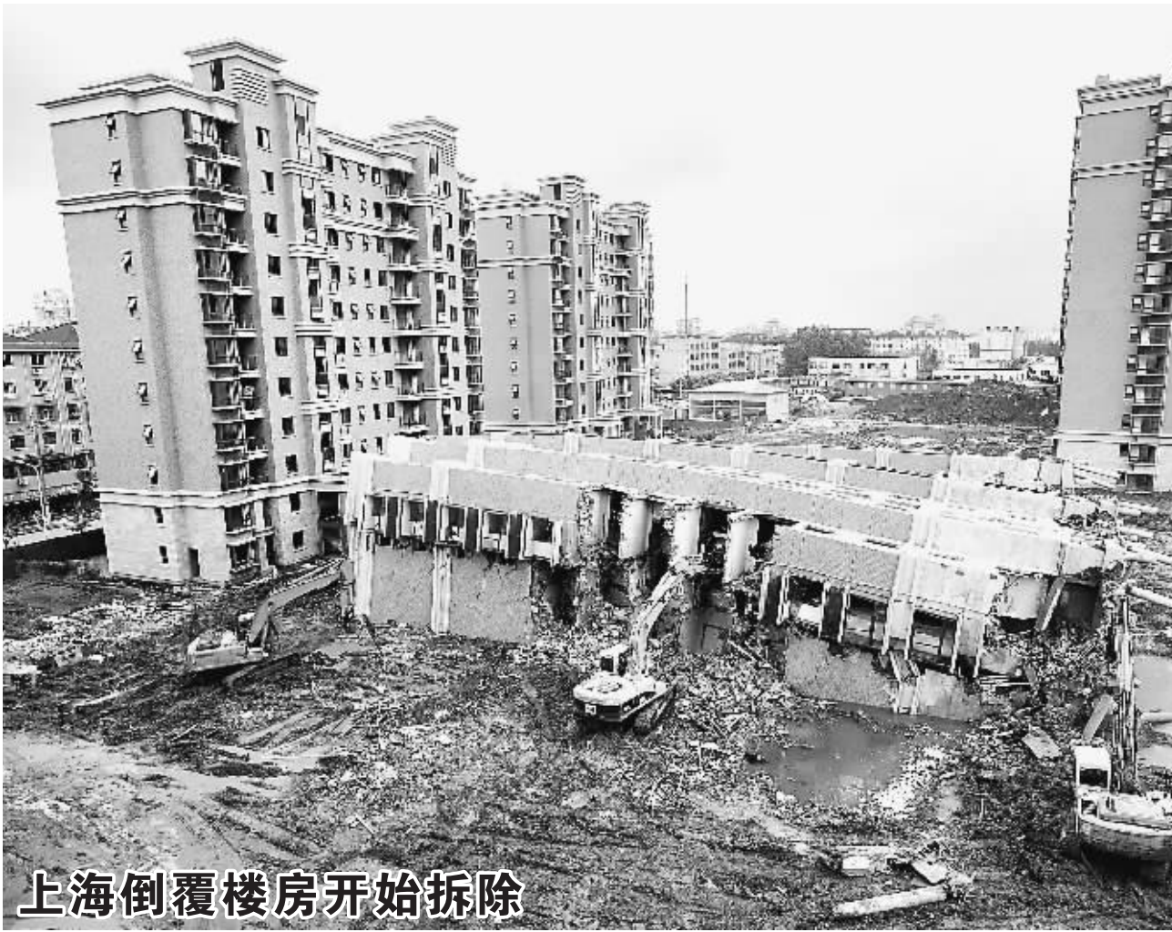
上海倒覆楼房开始拆除 8 月 5 日,上海市闵行区“莲花河畔景苑”倒覆楼房开始拆除,整个拆除工作预计一周左右完成,之后,万科房地产有限公司将作为第三方托管未倒覆楼房的后续建设。图为工程车辆正在拆除倒覆楼房。
