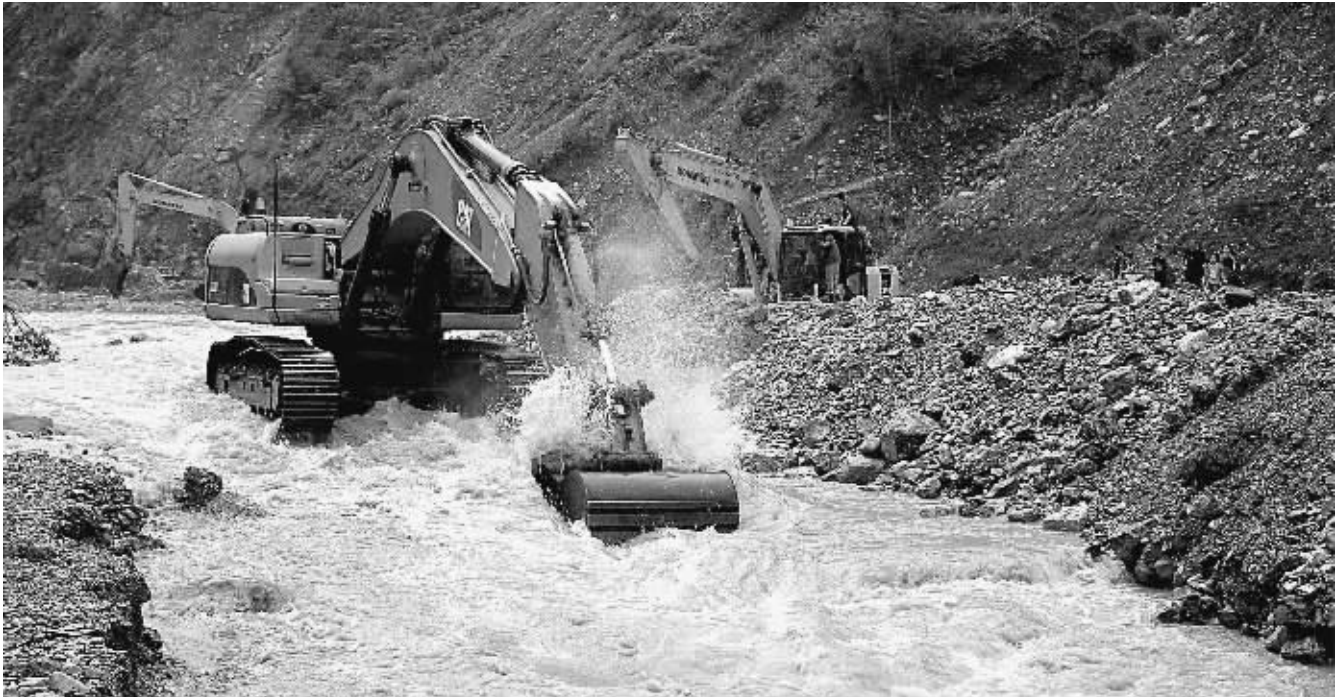
安县组织大型机械，集中抢险晓茶路向阳坪段水毁道路。
