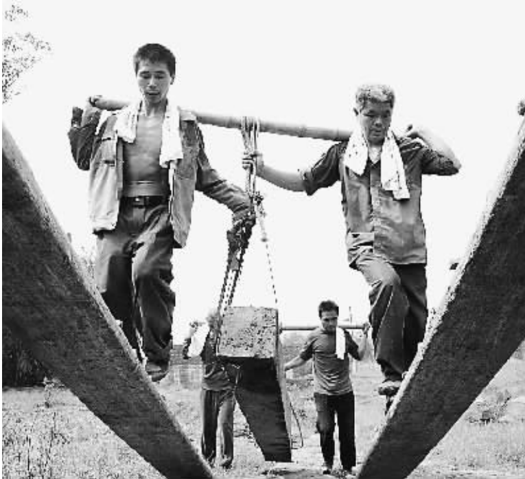
重庆市荣昌县农民积极修建农田水利工程。 朱芸摄(资料照片)
