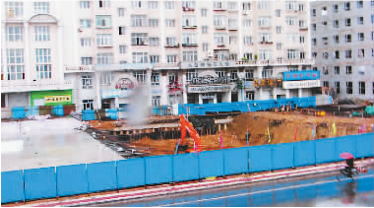
紧挨居民楼的大深坑。
