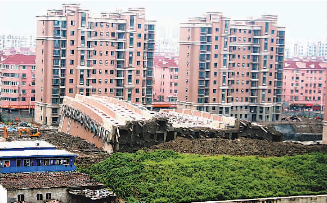
倒塌的楼房位于河边，底部折断的水泥柱裸露在外。
