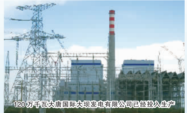
120万千瓦大唐国际大坝发电有限公司已经投入生产
