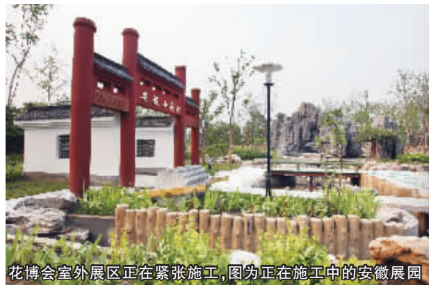
花博会室外展区正在紧张施工,图为正在施工中的安徽展区
