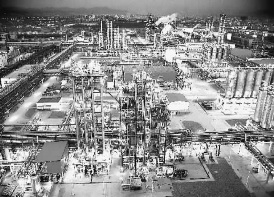
图为新建成的兰州石化大乙烯厂区。 习 轩摄
