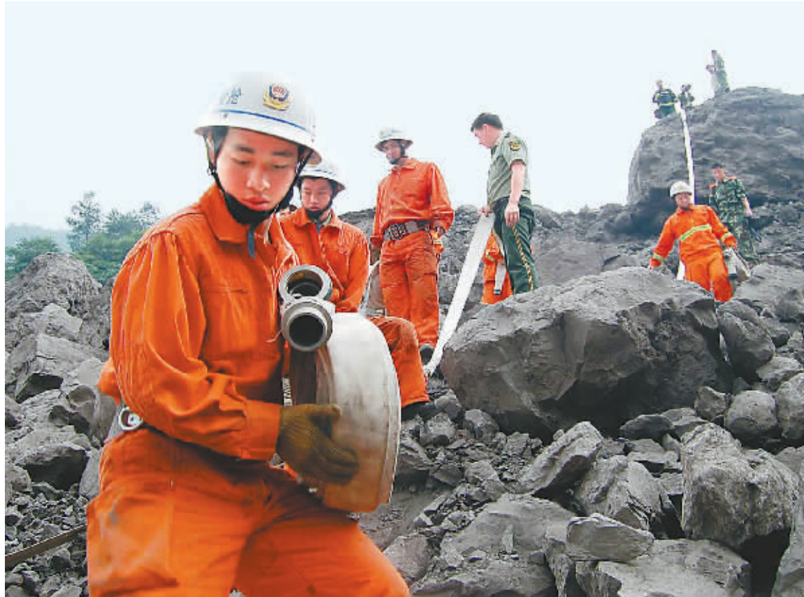
6月7日，几名消防战士在山体垮塌现场铺设水带，为钻填火药炸孔的钻头供水冷却。 蒋勇摄 新华社发
