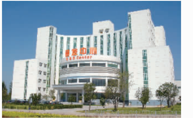
国家重点高新技术企业——河南黄河旋风集团公司研发中心大楼
