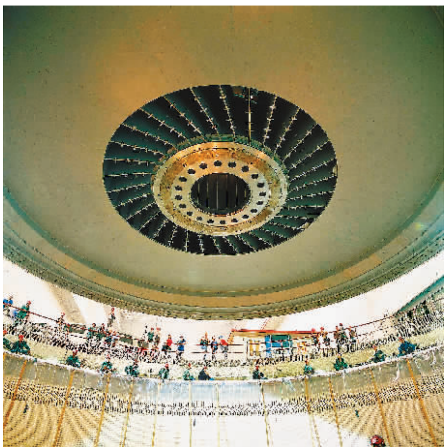
三峡电站机组转轮正吊入机窝(资料照片)。
