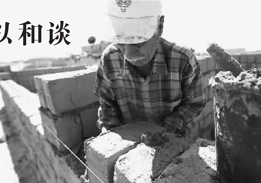
5 月 11 日,在加沙地带南部的拉法,巴勒斯坦工人用黏土砖建造房屋。以色列对加沙发动的军事行动造成巨大破坏。因缺乏建材,人们因陋就简重建家园。
