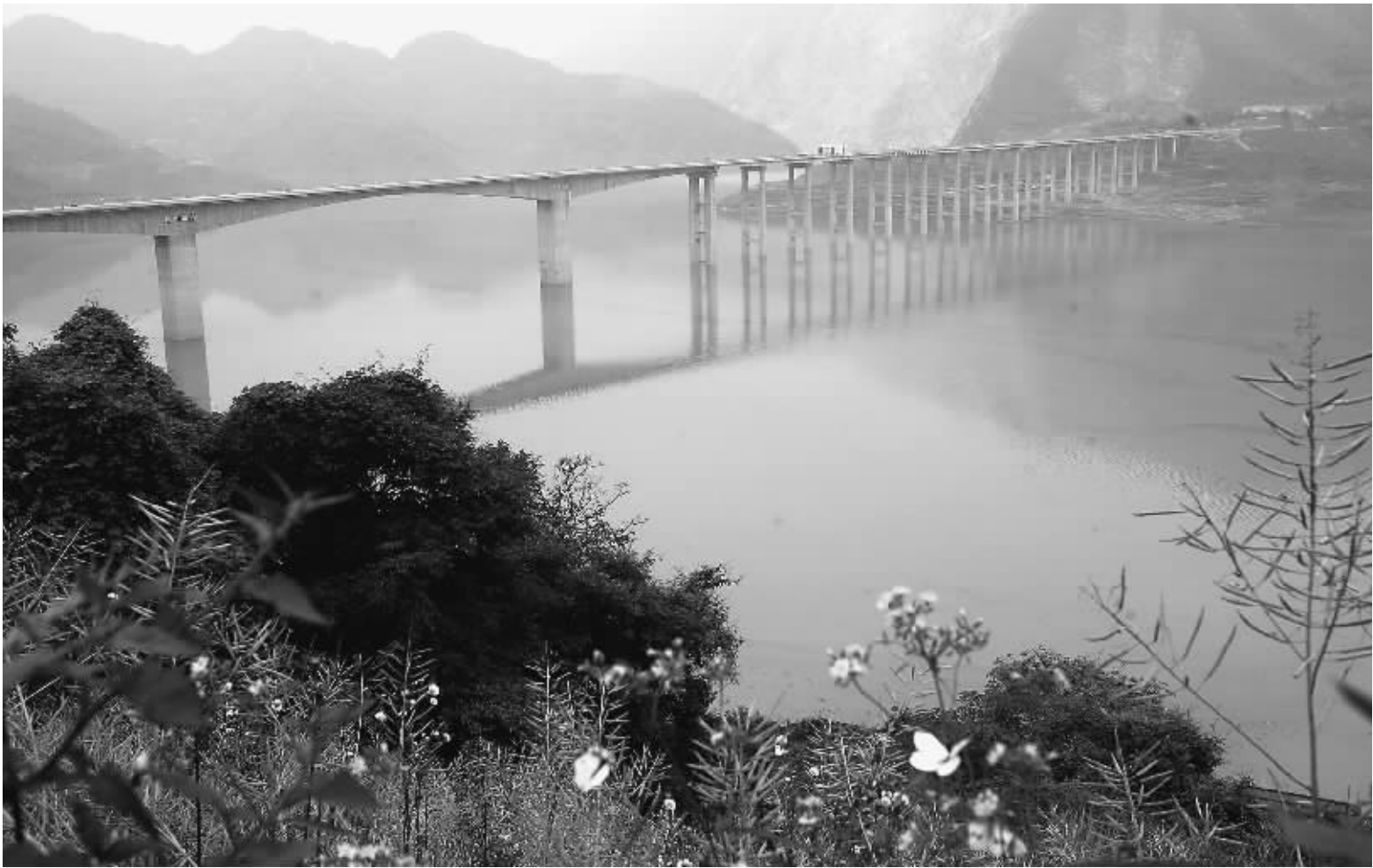
5月10日，在“5·12”汶川大地震中毁坏断裂的都江堰至映秀镇高速公路桥基修复，12日大地震一周年之日通车。何 毅摄（人民图片）
