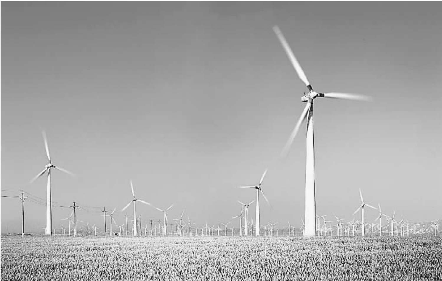
今年一季度,国电龙源集团风电发电量共完成 16 亿千瓦时,同比增幅 86%。图为新疆天风发电公司二场场区。
