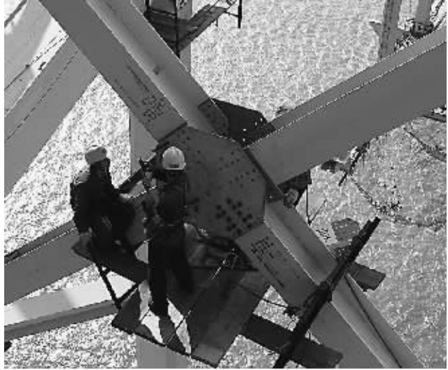
5月3日,工人们在高空作业。当日,国家重点工程——京沪高铁南京大胜关长江大桥建设者坚持奋战在工地,确保大桥主跨 9 月上旬合龙、全桥贯通。张剑肥摄(新华社发)
