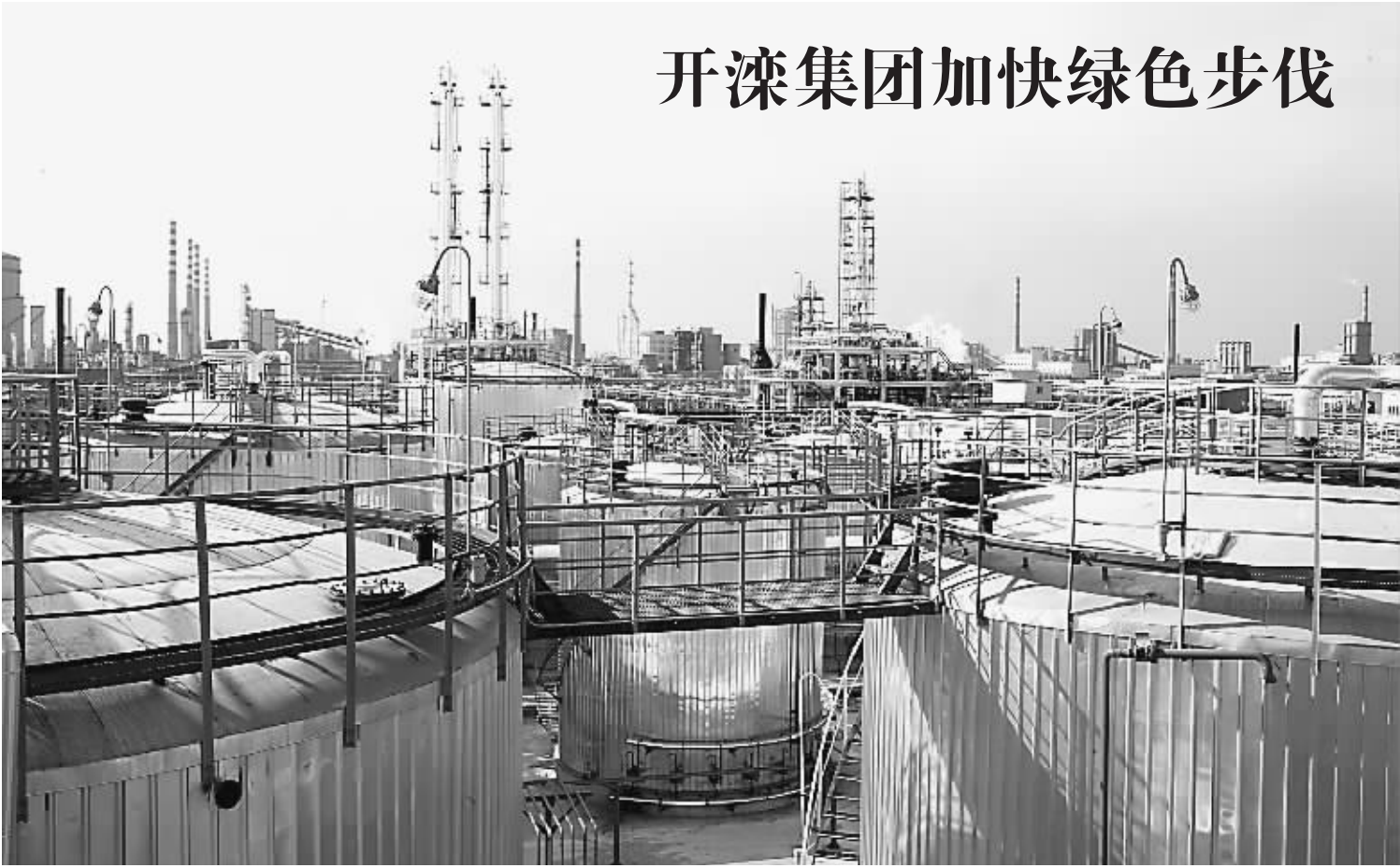
总投资3.7亿元的唐山考伯斯开滦焦炭化工有限公司30万吨项目日前正式投产。该项目是开滦集团在京唐港建设绿色可循环煤化工工业区的重要环节，是目前国内单套规模最大的生产装置之一。
