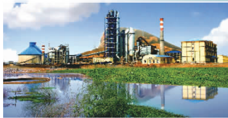
武穴市先后引进华新、亚东等一批大运量的建材企业,达到1000万吨水泥年生产能力,成为华中地区最大水泥生产基地之一。图为华新水泥(武穴)有限公司厂区厂景。
