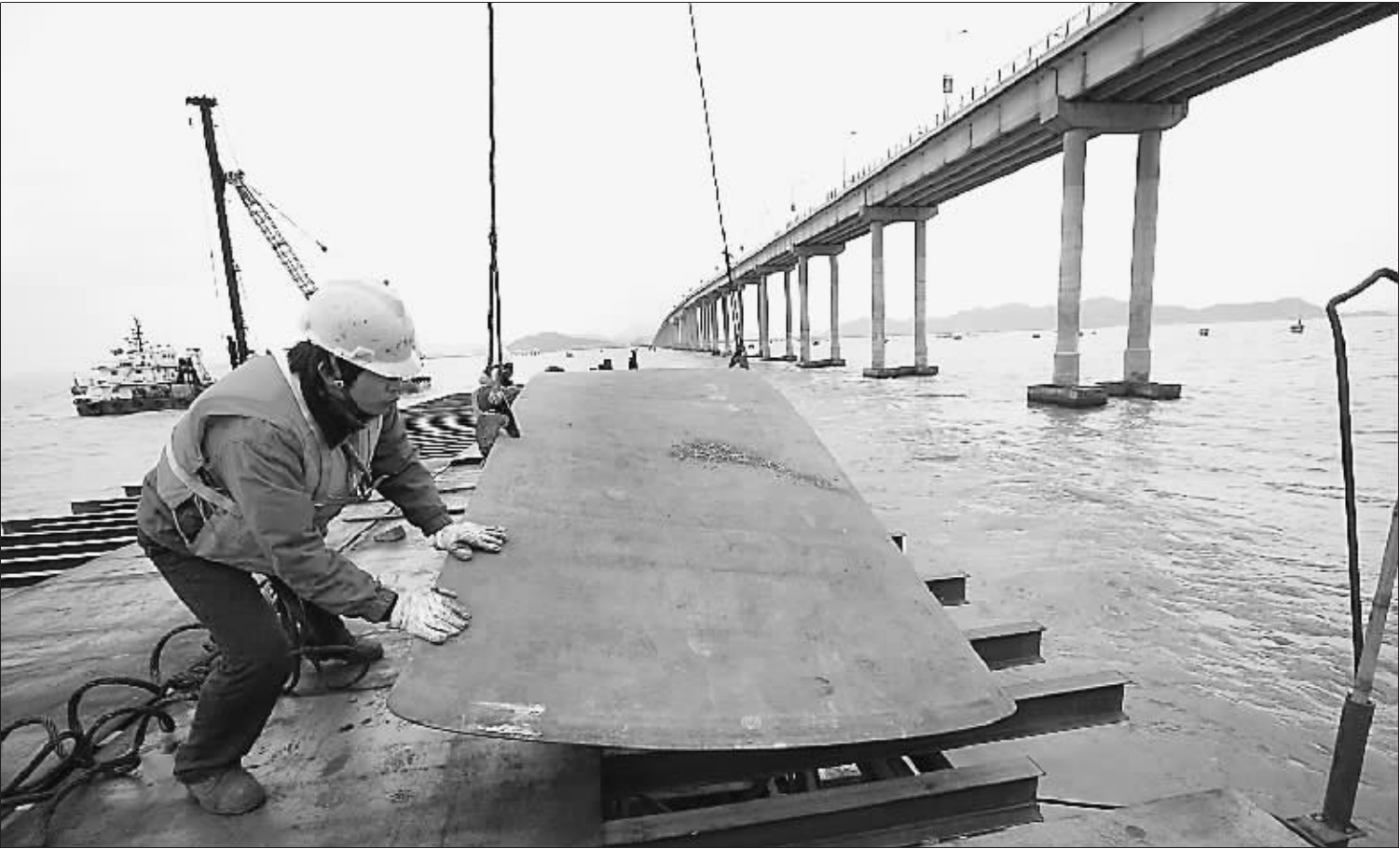
2009年3月23日,建设者正在为浙江省舟山朱家尖大桥扩建工程铺设钢栈桥。据朱家尖大桥扩建工程相关负责人介绍,朱家尖大桥扩建工程全长4.3公里,总造价3亿多元,工程将于2011年完工并通车。胡社友摄
