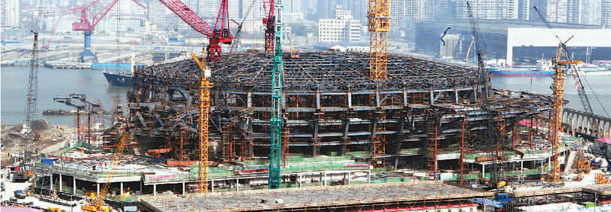
3 月 20 日,上海世博演艺中心钢结构吊装施工进入最后冲刺。演艺中心是世博永久性场馆中开工最晚、工期最紧、单体钢结构体量最大的工程,将在世博期间承担各类大型演出。世博演艺中心钢构件总吨位 3.4 万吨,预计本月底完成全部吊装工作。世博演艺中心位于世博园区东北角,飞碟状的建筑外形时尚现代,犹如黄浦江畔的一只“贝壳”。
