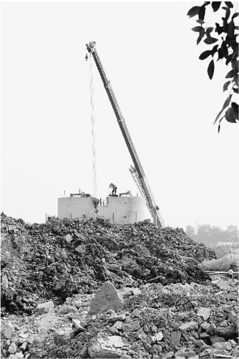
2月12日,一名工人在武广铁路一处桥墩上施工。不久前,这里正是“钉子户”的房屋所在。
