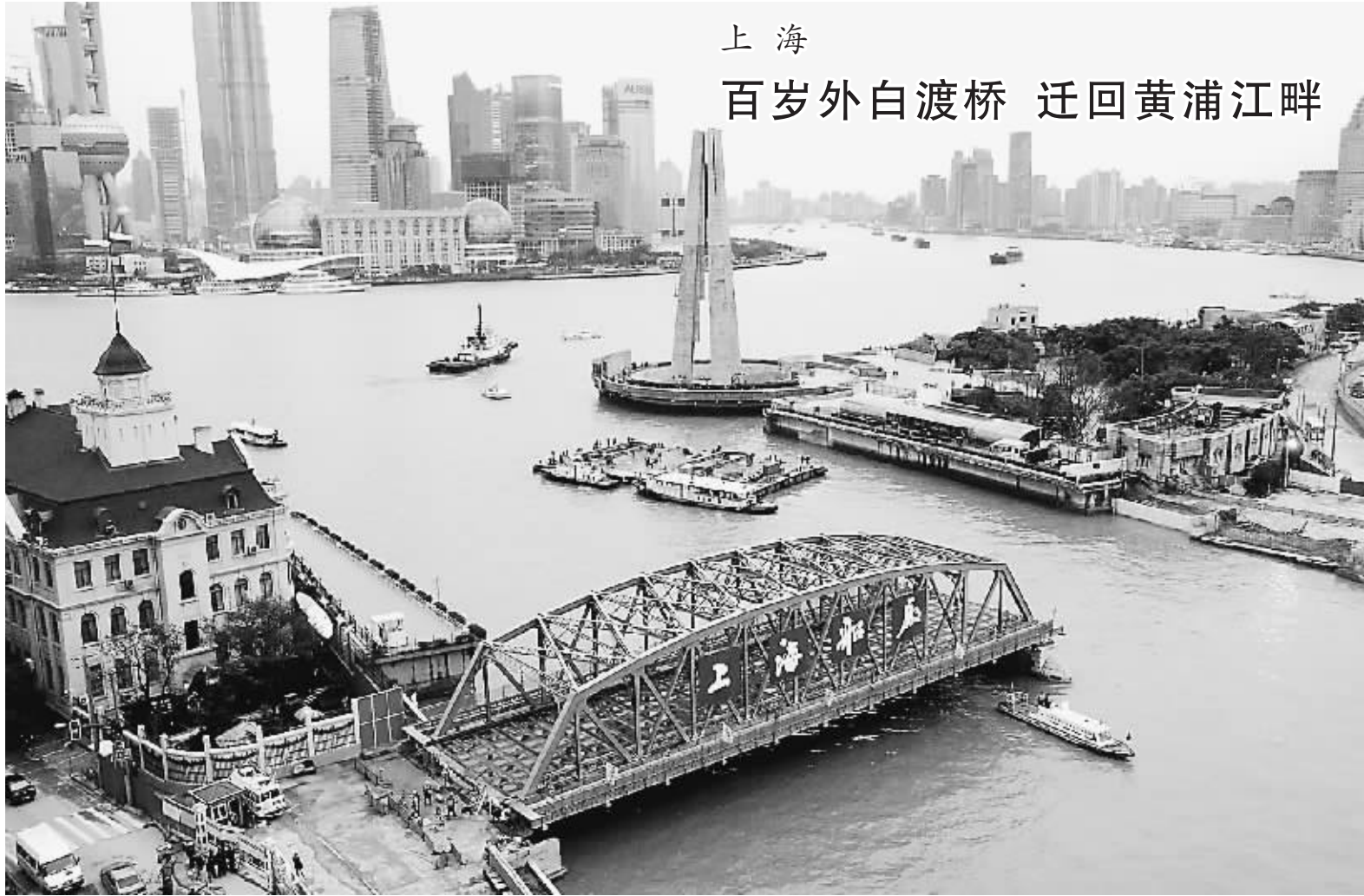
2 月 25 日,上海著名的百年老桥外白渡桥,经过近 1 年的检修,北段桥身重新横跨在黄浦江畔的苏州河口口,南段桥身于 26 日回归原位,以原汁原味的历史风貌继续见证上海城市发展的历程。
