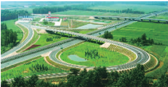
四通八达的徐州高速公路
