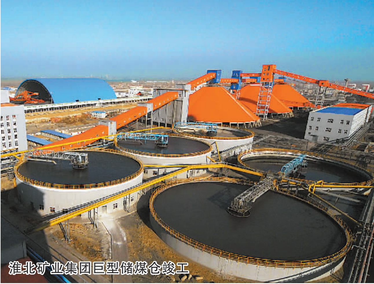
1月12日，在亚洲最大的冶金煤选煤厂——安徽省淮北矿业集团临涣选煤二厂，技术人员对巨型锥形储煤仓顶部进行了收尾加固作业。据悉，该工程是安徽省“861”重点工程配套项目，煤仓采用国内最先进的钢网架穹顶框架结构，每座最大直径80米、高38米，总储量达300多万吨。投入生产后不仅实现原煤从进厂到中煤、精煤洗选成品均在全封闭状态中生产，而且在提高产品质量的同时避免了生产过程中产生的噪音和粉尘等污染。图为临涣工业园内三座储煤仓外景。 陈帮干摄
