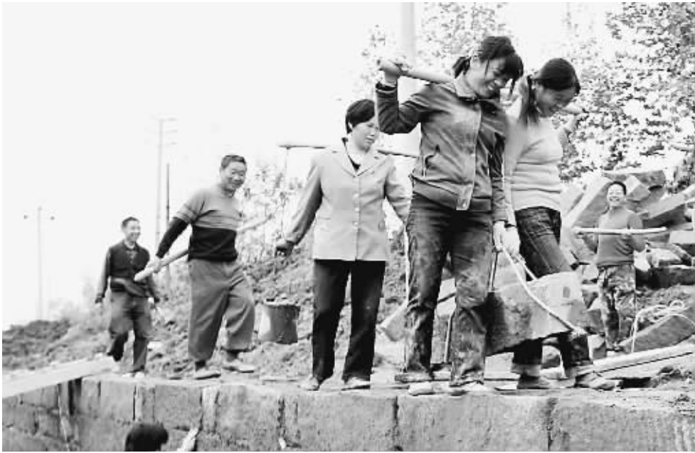
四川双流县凤凰村留守在家的妇女积极参加农田水利建设。图为 11 月 19 日,妇女们在水利工地抬石头。 邱海鹰 袁 浩摄影报道
