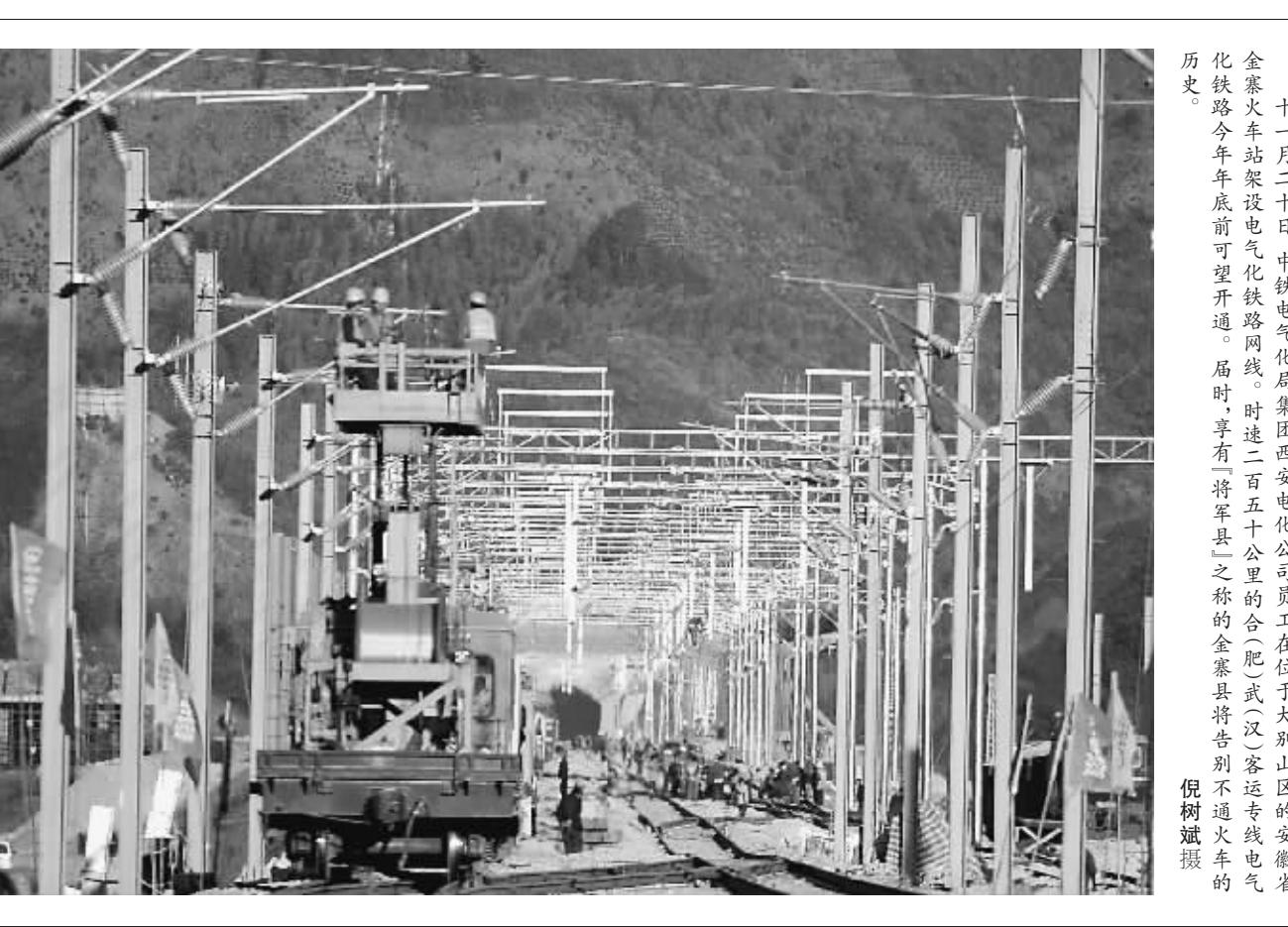
十一月二十日，中铁电气化局集团西安电化公司员工在位于大别山区的安徽省金寨火车站架设电气化铁路网线。时逾二百五十公里的合（肥）武（汉）客运专线电气化铁路今年年底前可望开通。届时，享有「将军县」之称的金寨县将告别不通火车的历史。
