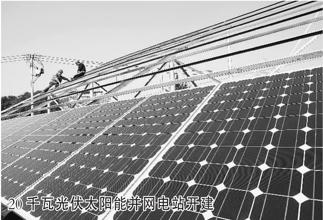
11 月 12 日,安徽省电力公司试验项目“20 千瓦光伏太阳能并网电站”在巢湖 110 千伏柘皋变电所开建。按照设计要求,电站通过 200 多平方米的太阳能电池板采集的绿色能源,将直接并网发电,最大功率 20 千瓦,年均可发电 3 万千瓦时左右。图为技术人员在安装光伏电池板。赵育鸣摄
