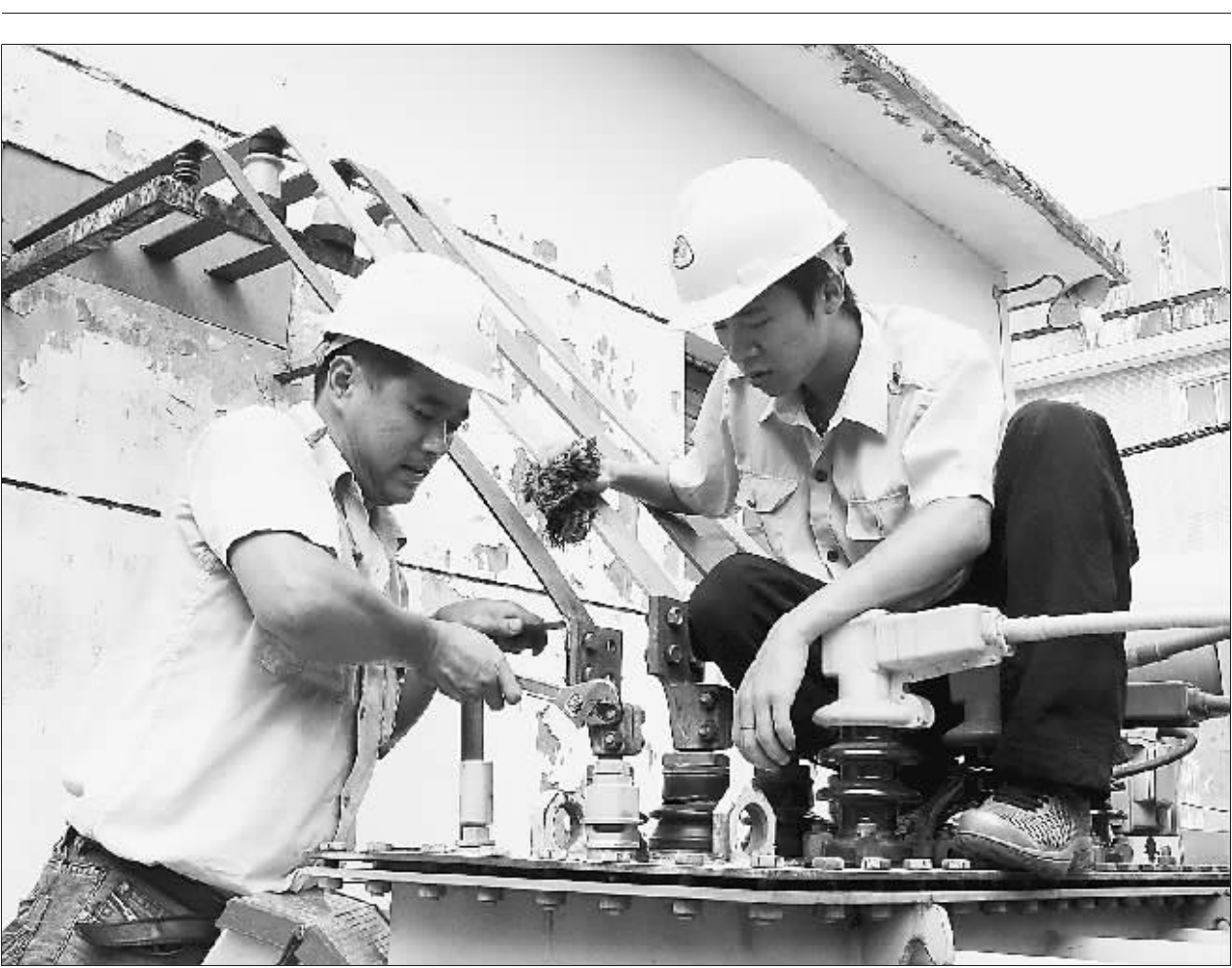
为确保“十一”黄金周铁路正常运行和淮北矿区煤炭正常外运,安徽淮北矿业集团铁运处电务、车务、工务、机务四大工种对全线的设备线路开展安全检查检修,筑牢铁路安全防线。图为电力工人正在检修设备。
