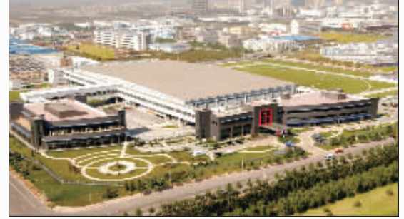
已形成一条完整的移动通信产业链的星网工业园
