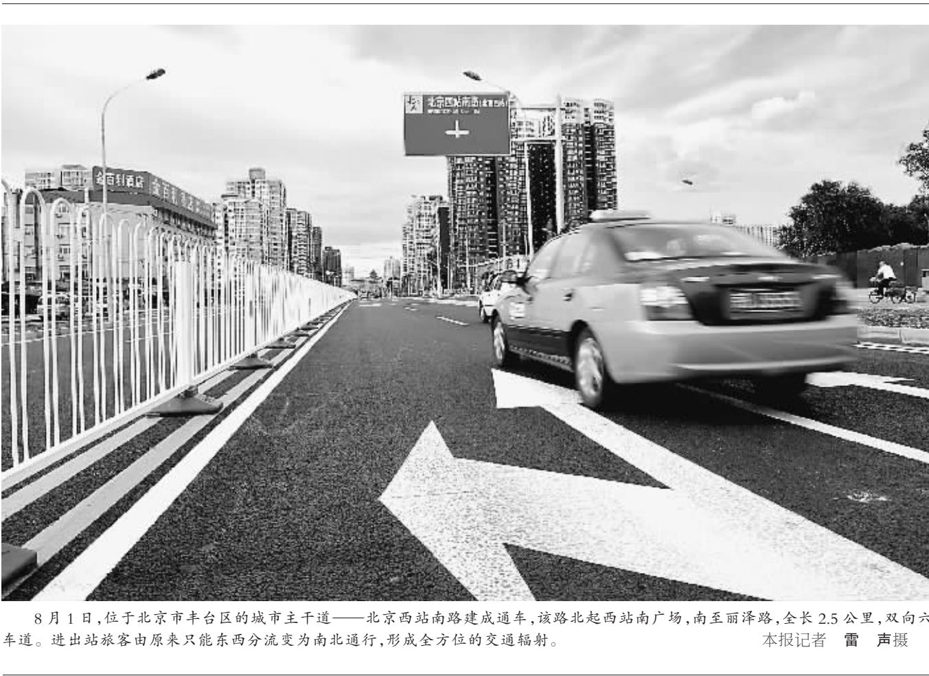
8月1日,位于北京市丰台区的城市主干道——北京西站南路建成通车,该路北起西站南广场,南至丽泽路,全长2.5公里,双向六车道。进出站旅客由原来只能东西分流变为南北通行,形成全方位的交通辐射。 本报记者 雷 声摄
