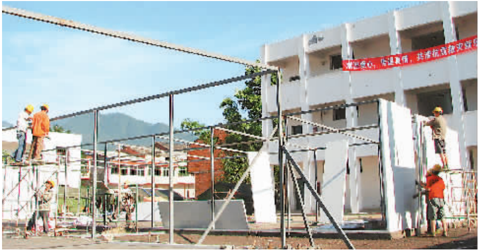
河南洛阳在四川江油市文胜小学的援建队伍加紧施工。
