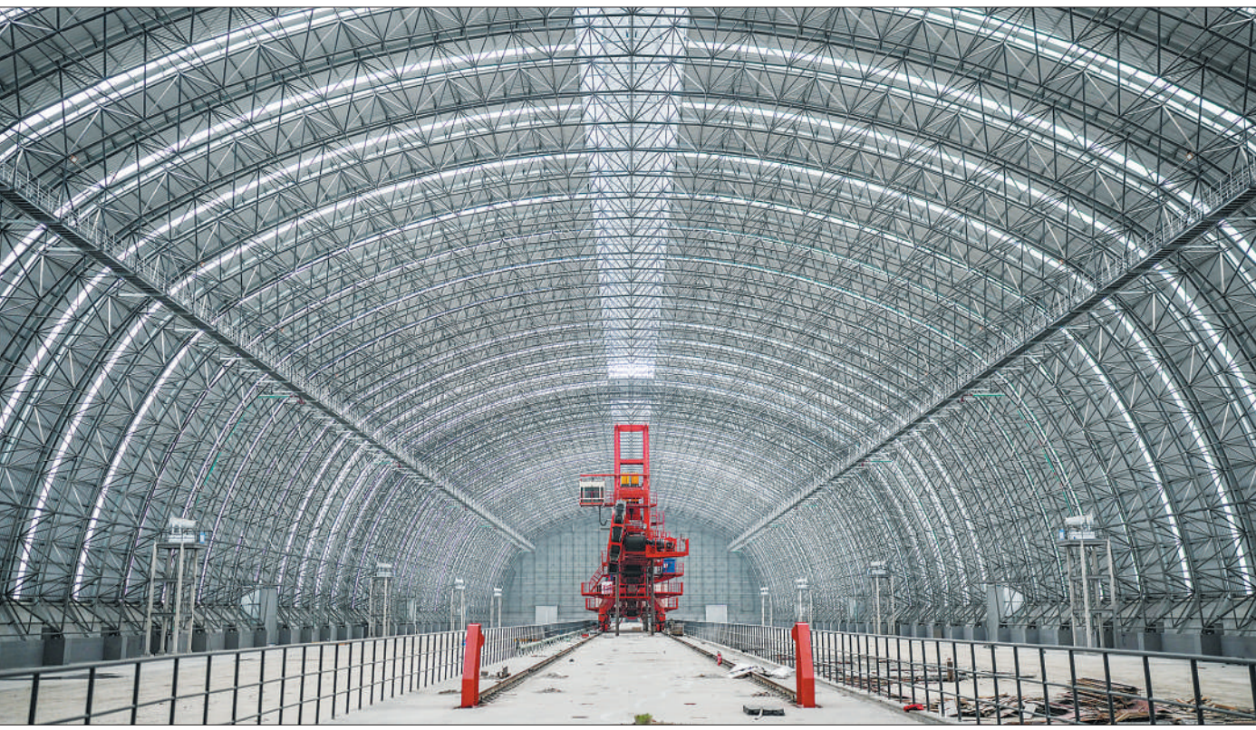
近日，贵州多地煤炭储备基地施工有序进行。当地依托丰富的煤炭资源，建设煤炭储备基地，打造西南地区煤炭保供中心，助推区域经济发展。图为主体结构建设完成的六盘水市水城区煤炭储备基地2号储煤场。
