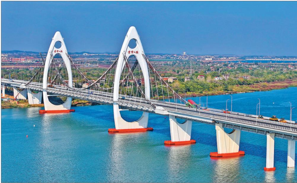
江西省丰城市紫云大桥是双塔双索面组合梁自锚式悬索桥，全长约5.5公里，按照一级公路兼城市主干道标准建设。大桥建成后，有助于统筹区域城乡发展，为当地群众出行和物流运输提供新的快速交通通道，推进老区高质量发展和乡村全面振兴。图为11月28日拍摄的紫云大桥建设工地，沥青摊铺机、压路机等设备正来回作业，桥梁建设收尾工作有序推进。
