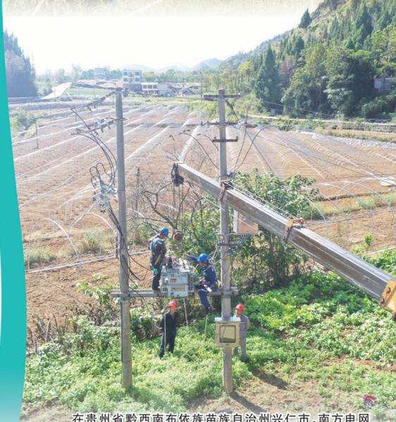
在贵州省黔南布依族苗族自治州兴仁市，南方电网工作人员对配电变压器进行扩容更换，保障冬季高负荷台区电压稳定
