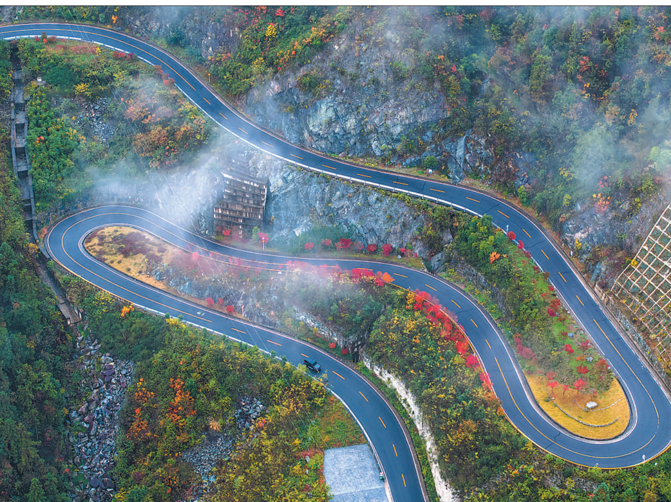
近年来,湖北省秭归县加大“四好”农村公路建设和维护力度,让平整畅通的公路成为山区群众产业发展的致富之路,助力乡村全面振兴。图为秭归县茅坪镇的盘山公路。
