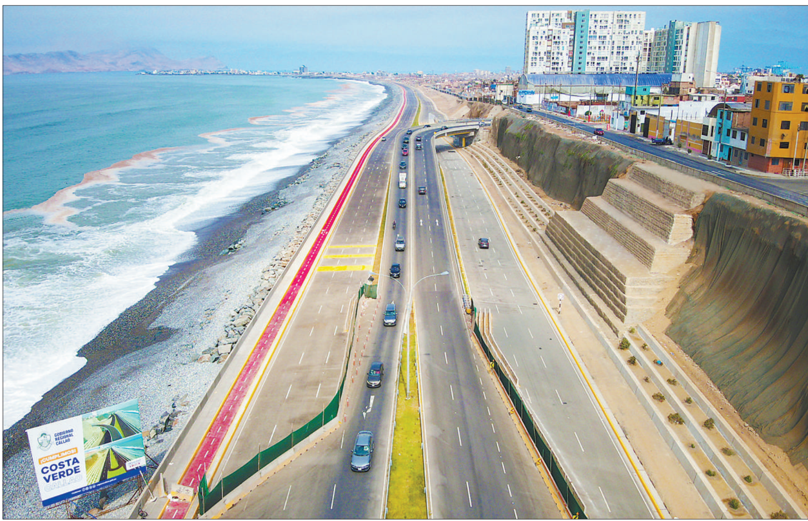
由中国电建水电十一局承建的卡亚俄绿色海岸公路项目是秘鲁绿色海岸公路的关键路段。该项目包括全长4.83公里的双向6车道市政公路、两座立交桥以及沿线绿化景观带、海岸防护工程等，改善了当地生态环境，缓解了海边高速公路的交通压力。
