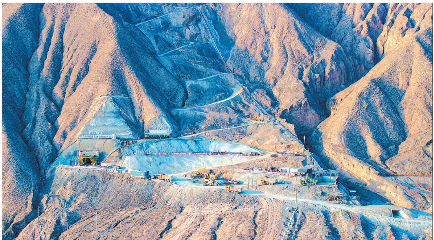
11月16日，甘肃省张掖抽水蓄能电站建设现场，施工作业正在进行。张掖抽水蓄能电站是国家和甘肃省“十四五”规划的重点工程，总装机容量1400兆瓦，建成后将提高河西走廊电网调节能力，促进新能源消纳，在能源结构调整中发挥作用。
