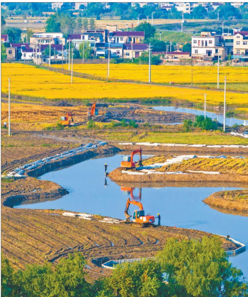
11月2日，安徽省芜湖市繁昌区郭仁村，新建新平灌区项目在施工中。项目通过对现有灌区实施新建灌溉站及信息化工程、整治调蓄区和灌排渠道等措施，保障灌区供水安全、粮食安全、生态安全。肖本祥摄（影像中国）
