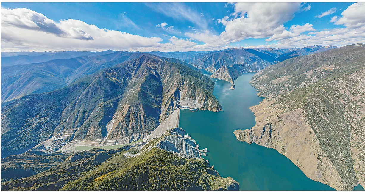
10月25日,我国海拔最高的百万千瓦级水电站——两河口水电站蓄至正常蓄水位2865米。这标志着我国第三大水电基地雅砻江的中游龙头水库电站首次满蓄。图为雅砻江两河口水库全景。新华社发
