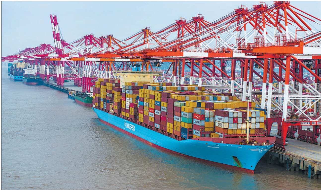
2023年,上海港集装箱吞吐量连续第十四位居世界第一。图为桥吊林立的上海港洋山深水港区。 计海新摄(影像中国)
