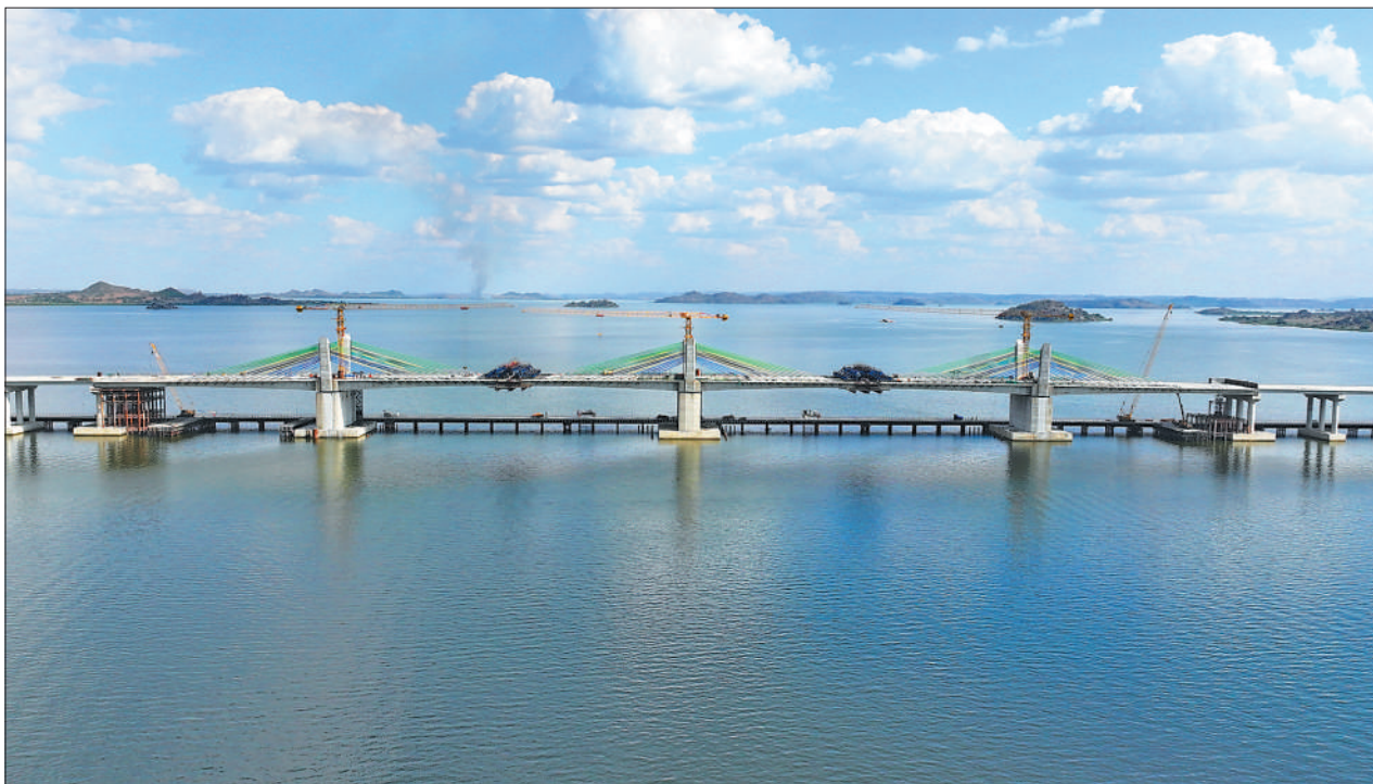
近日,由中国土木和中铁十五局联合承建的坦桑尼亚马古富力大桥主桥顺利合龙。马古富力大桥是坦桑尼亚重要的内陆国际通道,建成后将成为非洲最长矮塔斜拉桥,对提升坦桑尼亚国家形象、推动周边地区社会经济发展有着重要意义。图为中国土木东非公司供图
