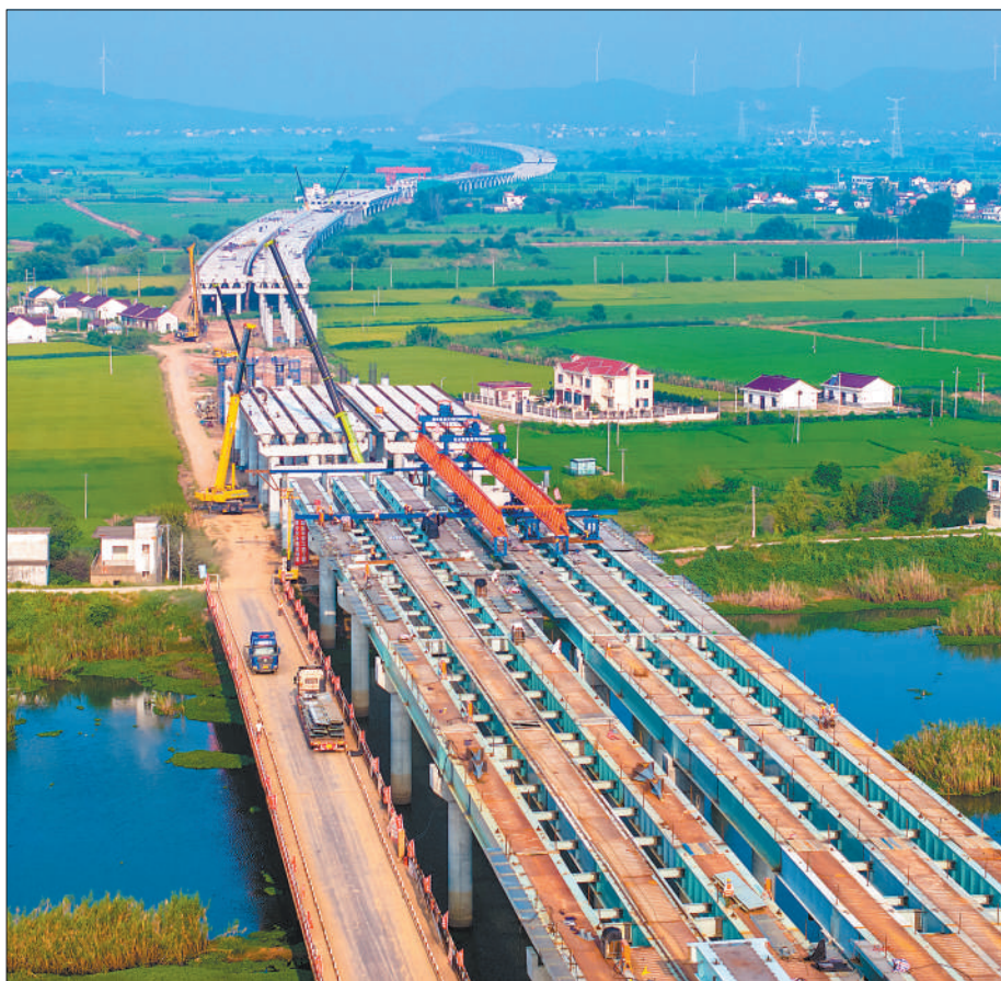
安徽省无为市开城镇，建筑工人在铜商高速公路永安河特大桥工地上进行钢箱梁架设作业。
