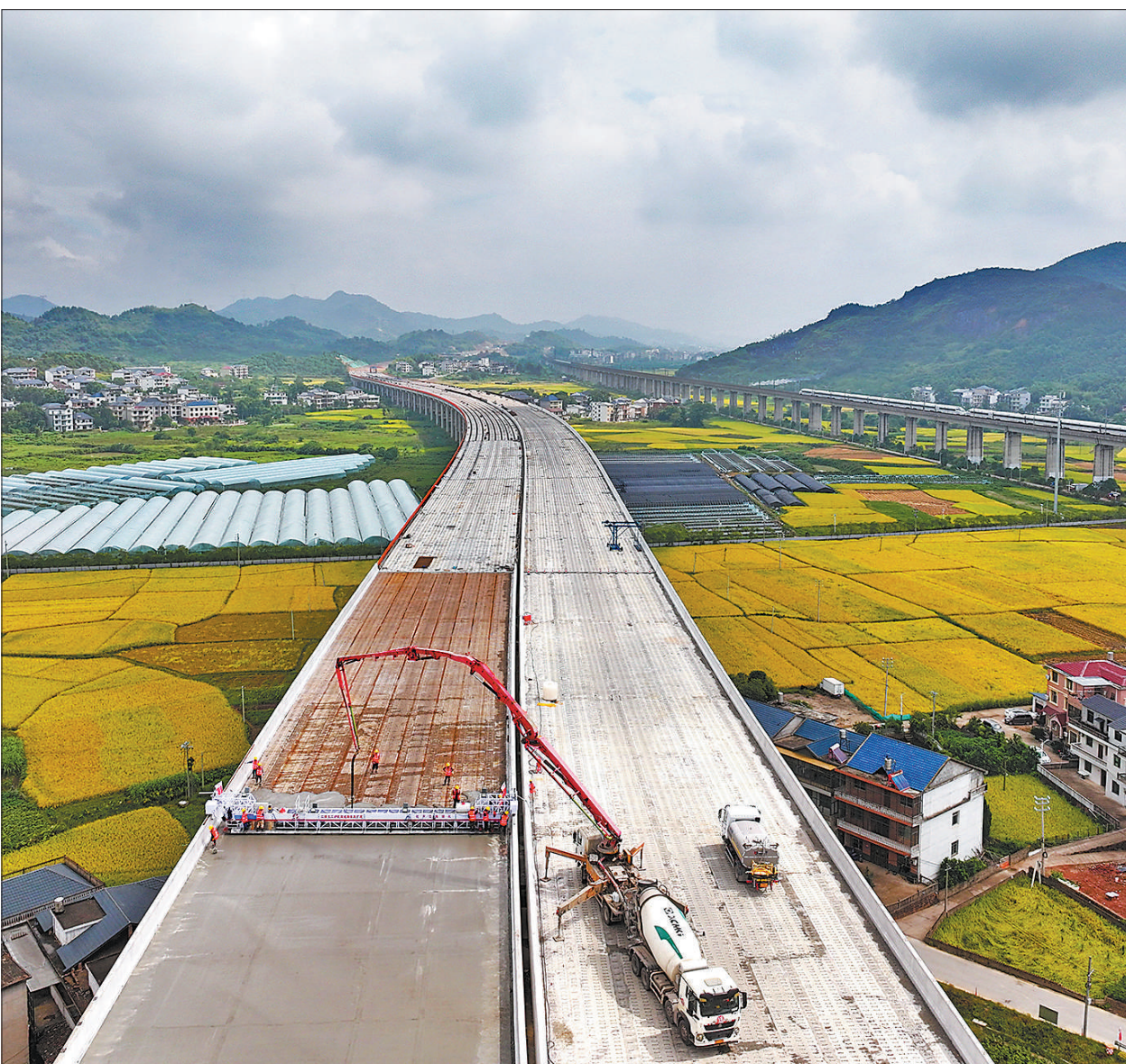
位于江西上饶的吸上特大桥是沪昆高速梨东改扩建项目的重要一环，桥梁全长1778米，设计为双向八车道。由于全桥80%桩基位于溶蚀区，该项目采用预压浆工艺、全工序智能集成梁板预制等多项创新技术保障工程质量。图为吸上特大桥建设现场。
