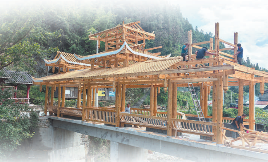
贵州省黔东南苗族侗族自治州黎平县尚重镇务弄村,掌墨师吴芳宇团队正在建造风雨桥。 苏滨摄
