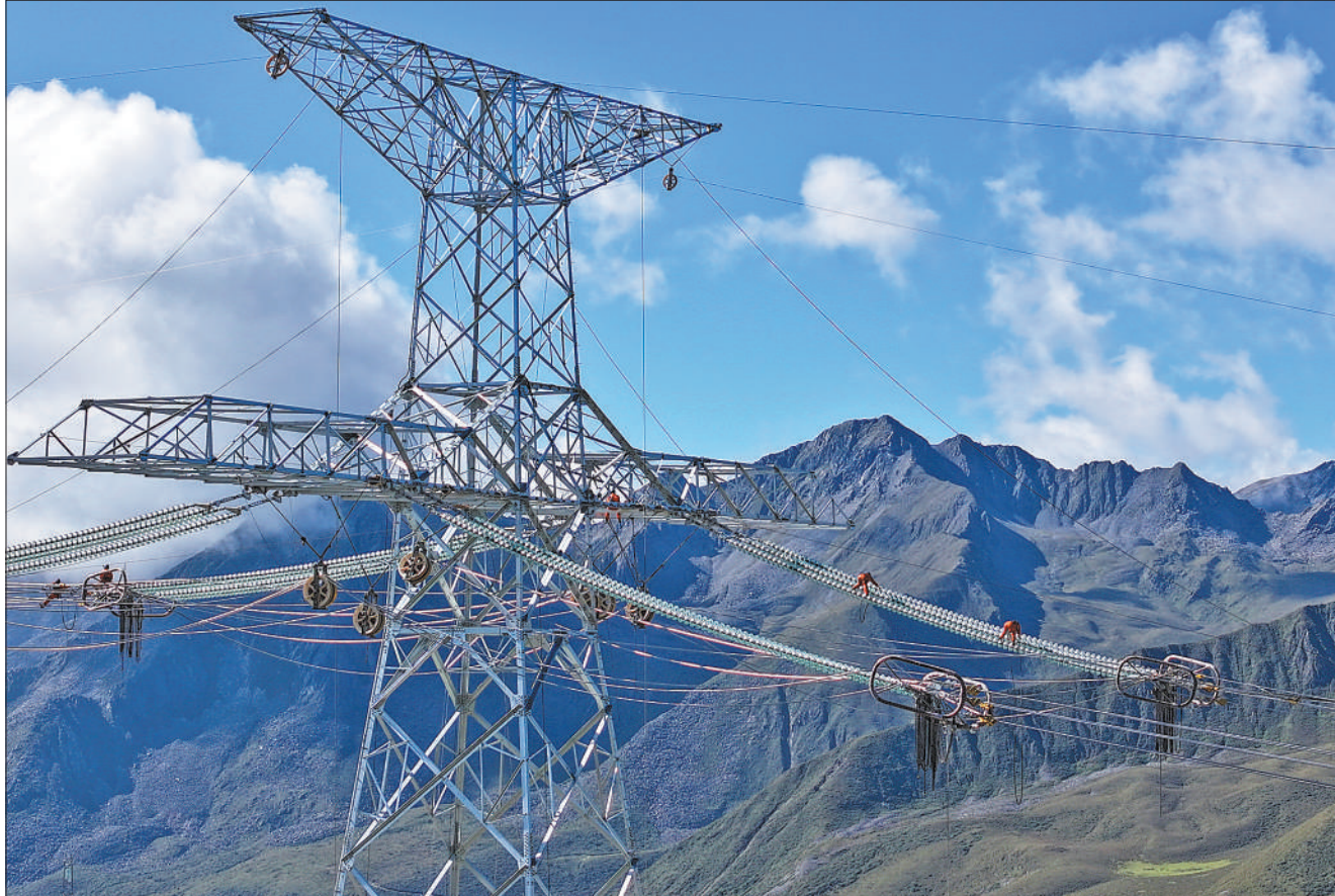
±800千伏金沙江上游至湖北特高压直流工程是目前国内海拔最高的特高压直流输电工程，作为我国“西电东送”大动脉之一，该工程途经四川省康定市，穿越折多山垭口，建成后每年向湖北输送400亿千瓦时的电量。
