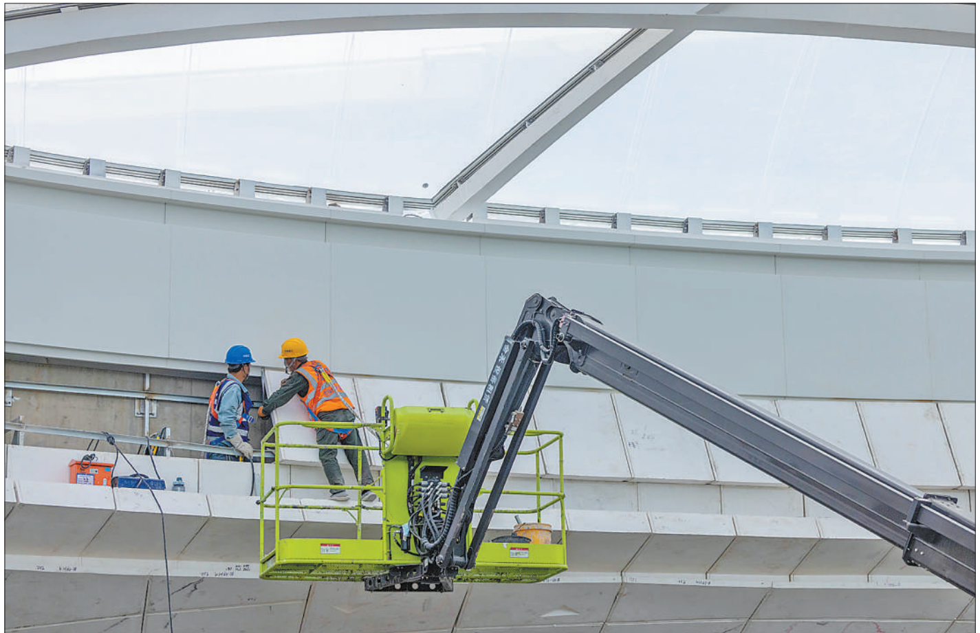
10月8日,工人在北京城市副中心综合交通枢纽工程02标段进行装饰装修施工。近日,北京城市副中心站综合交通枢纽的标志性建筑——“京帆”屋盖主帆实现封顶,标志着这一亚洲最大地下综合交通枢纽进入建设冲刺阶段。
