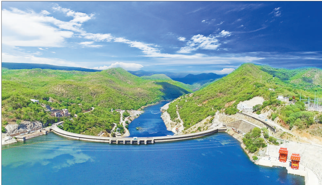
卡里巴南岸水电站扩机项目外景。
