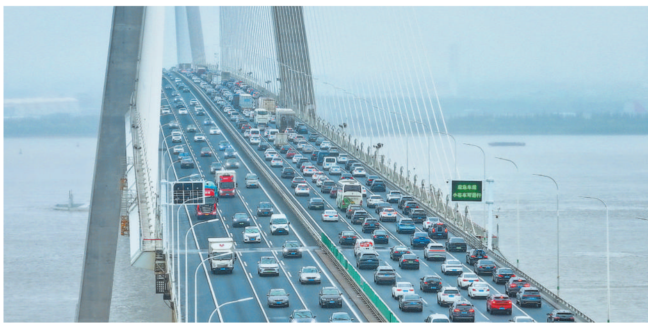
10月6日，各地陆续迎来返程交通流。图为6日拍摄的江苏南通苏通大桥车流。
