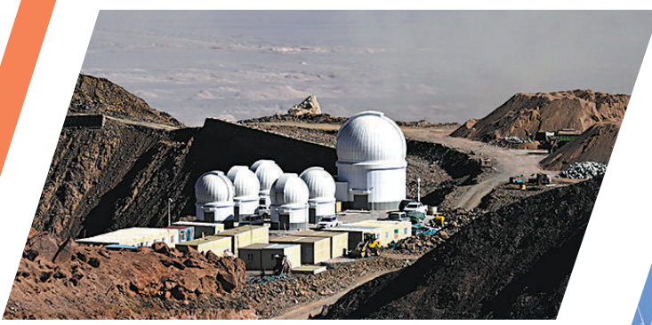
青海省茫崖市冷湖镇光学观测条件优越，随着冷湖天文观测基地的建设，这里将成为国际光学天文研究的重要基地、培育原创性科学成果的重要策源地。图为南京大学在冷湖镇赛什腾山实施的时域天文台TIDO项目。
