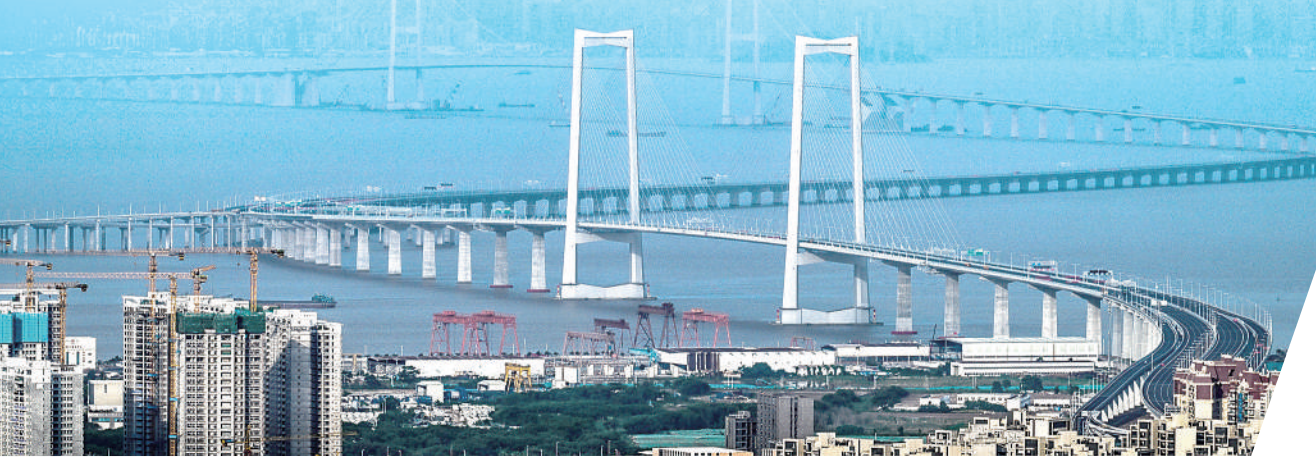
左图为国家重大工程深中通道，世界上综合建设难度最高的跨海集群工程之一。
