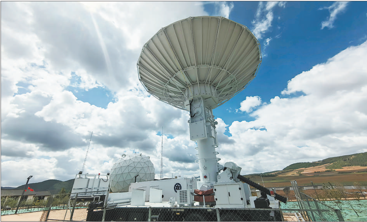
9月27日，中国遥感卫星地面站丽江站正式投入运行。位于云南的丽江站具备高效、全自动化卫星数据接收能力，填补了我国西南地区无固定式卫星地面接收站的空白。图为丽江站天线。中国科学院空天信息创新研究院供图（新华社发）
