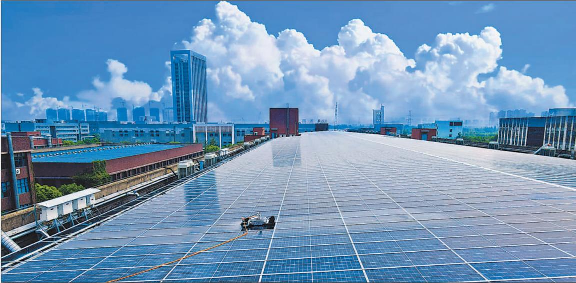
近日,浙江杭州市一家企业成功应用“光伏清洗机器人”。与传统人工清洗相比,机器人安全性高、速度快,清洗后光伏设备发电量实现提升。杭州供电部门通过一系列举措,有效提升新能源供应的稳定性和利用效率,目前杭州电网光伏发电装机容量达到375万千瓦。图为机器人正在清洗光伏板。陈丽摄(影像中国)
